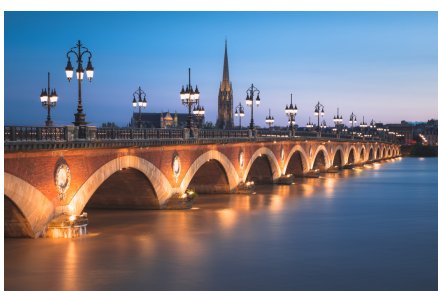
Pont de Pierre - Bordeaux
